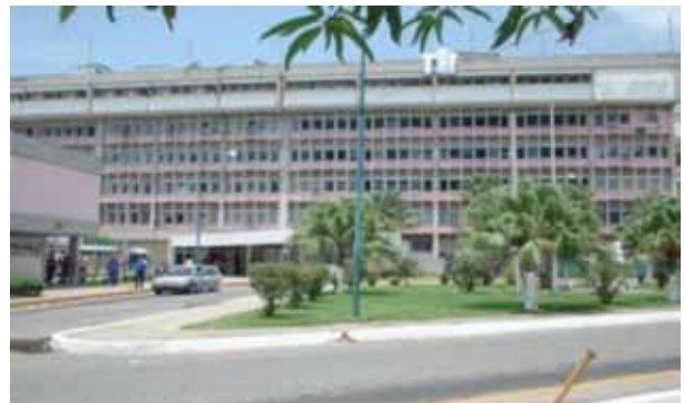
Figura 7. Nueva edificación inaugurada en 1976.
